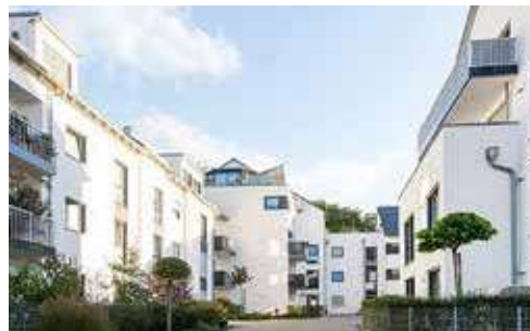
Wohnanlage in Schwabach
