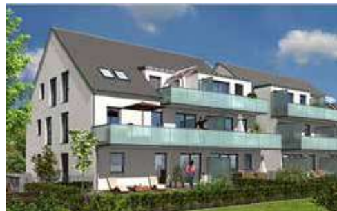
Wohnanlage in Schwabach
