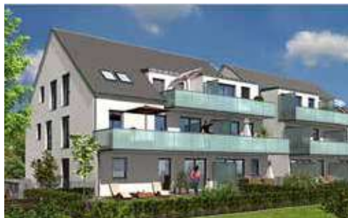
Wohnanlage in Schwabach Limbacher Str. 93+95
