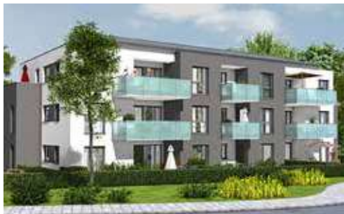
Wohnanlage in Wendelstein Sperbersloher Str. 27-33b
