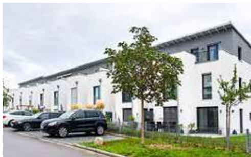
Reihenstadthäuser in Schwabach Spalter Straße 10-28
