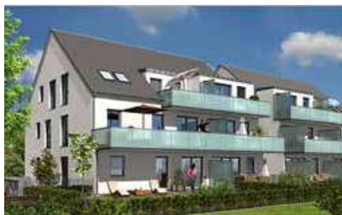
Wohnanlage in Schwabach Limbacher Str. 93+95
