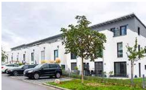
Reihenstadthäuser in Schwabach Spalter Straße 10-28
