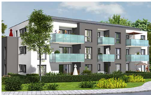
Wohnanlage in Wendelstein Sperbersloher Str. 27-33b
