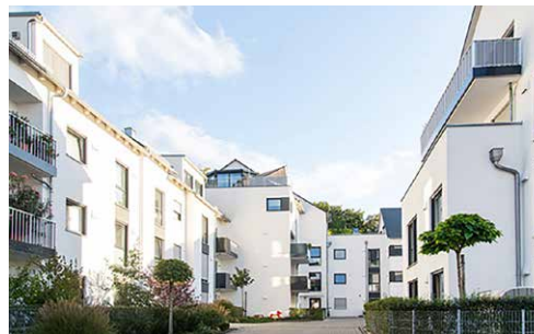
Wohnanlage in Schwabach Wilhelm-Friedrich-Weg 18-28
